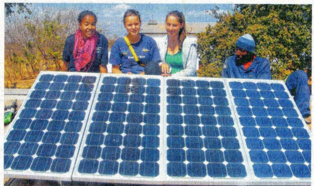
Vor Ort helfen die Partnerschüler einander beim Aufbau der Solarpaneele auf den Dächern der beiden Schulinternate in Sambia. FOTO: IDG
