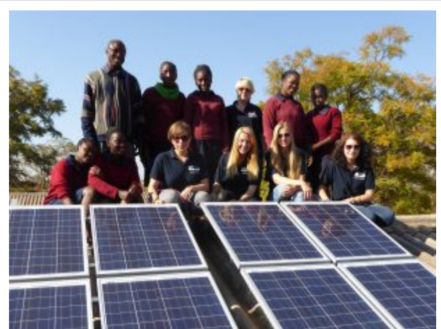
Die Austauschgruppe 2015 in Sambia mit der neu installierten Solaranlage.
